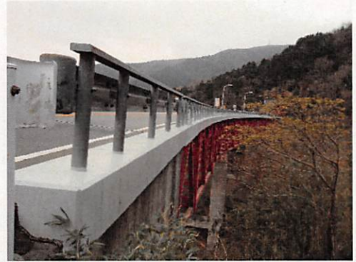
西熱海大橋 橋梁補修
