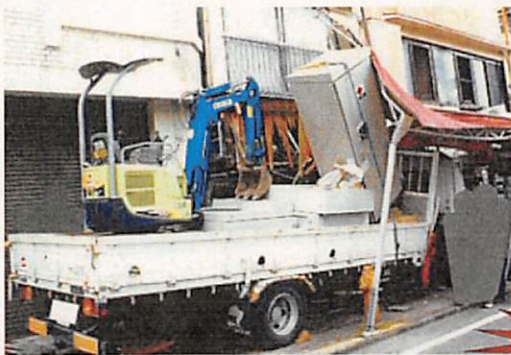
(主) 熱海函南線 事故状況
