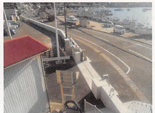
網代漁港 耐震陸閘
