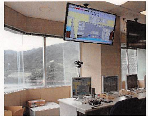
監視制御装置等設備の更新
