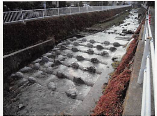
二級河川伊東宮川 魚道整備
